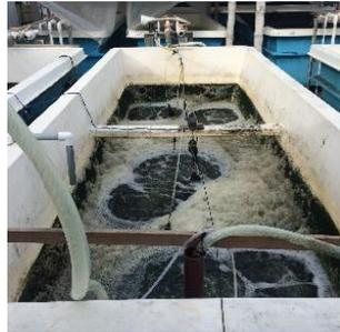
1.- Sistema de aireación encendido
