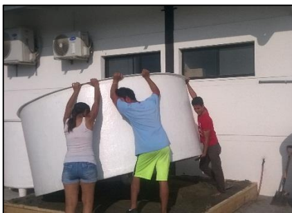
Figura 11. Acoplamiento de tanque en la cama de arena improvisada.
