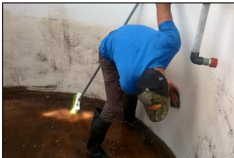
Figura 9.: Limpieza y preparación de tanque previa a la llegada de los huayaipes " S. rivoliana "
